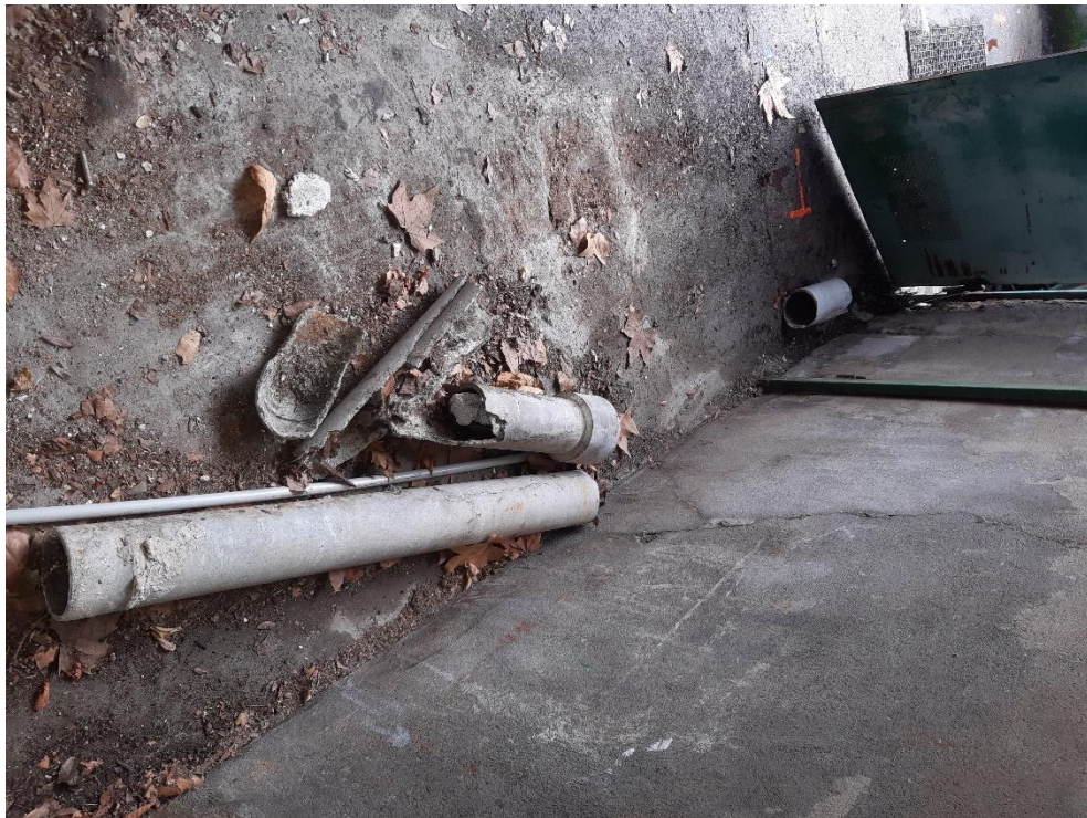
Débris de conduit fibres-ciment susceptibles de contenir de l'amiante présent au sol à l'entrée du bâtiment.
